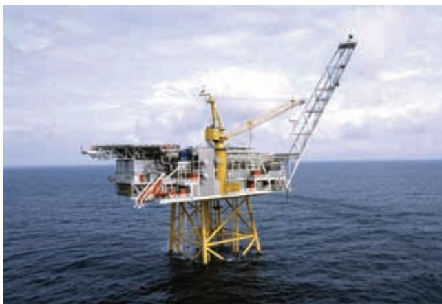
石油钻井平台
